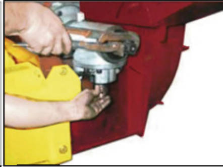
Imagen 14. Cambio del perno fusible
